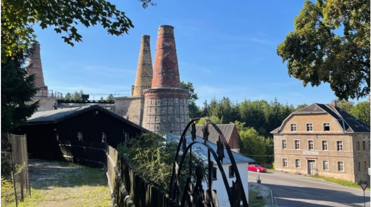
Das alte Kalkwerk mit den historischen Brennöfen unweit von Marienberg.
